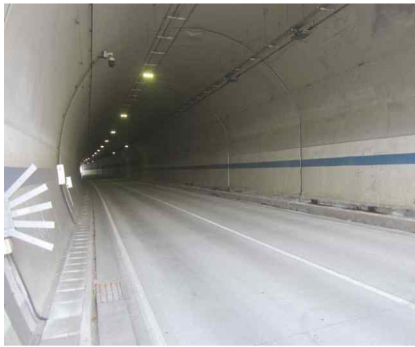
옥림터널(상) 전경 I
