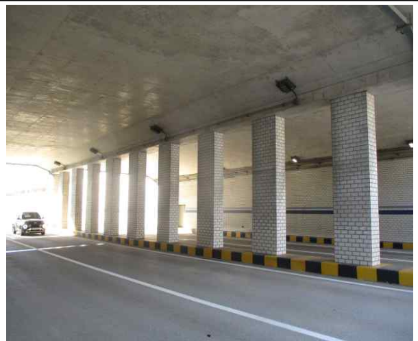
주교지하차도 전경 II
