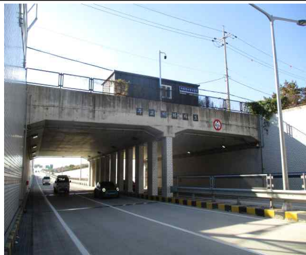
주교지하차도 전경 I
