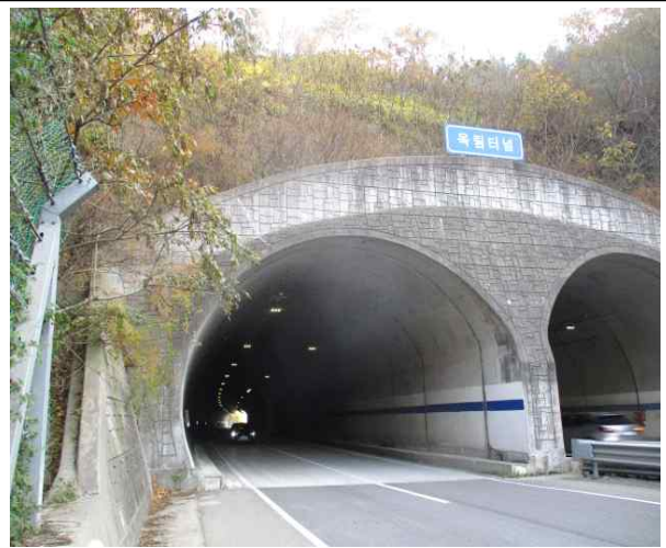
옥림터널(하) 전경 II
