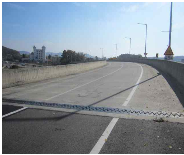
용정 Ramp-A교 전경 I
